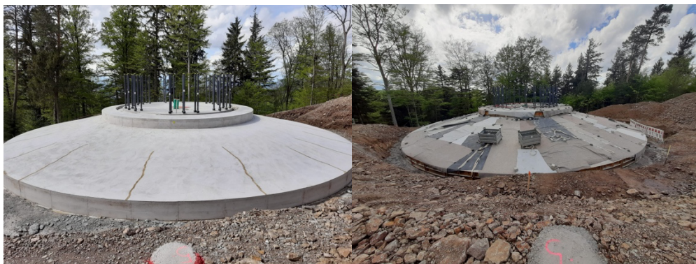
Foto 1 und 2: Fundament Windkraftanlage Taubenkopf
